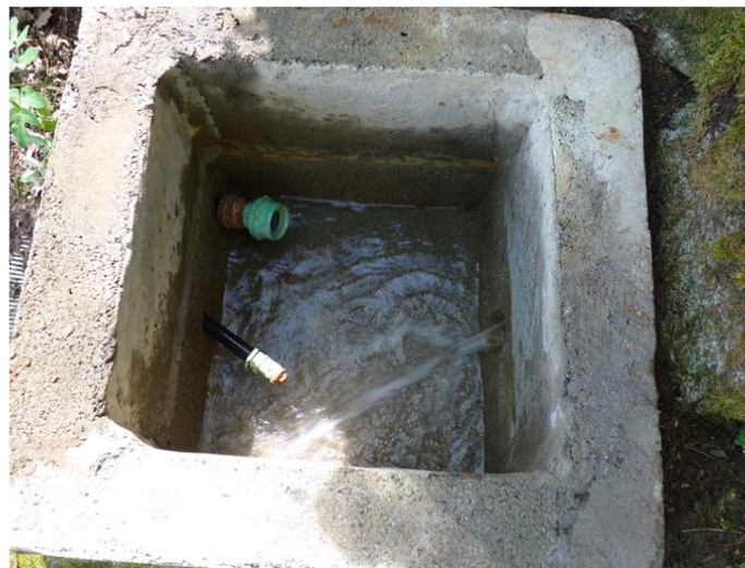
Figure 3 : Captages d'Artiguelongue (a : vue d'ensemble du répartiteur situé au droit du muret sous le sentier. Notez le trop plein ou la mesure de débit a été effectuée, b : vue depuis le sentier du répartiteur fermé, c : vue de l'arrivée d'eau dans le répartiteur, de la conduite de trop plein et de la conduite amenant au réservoir)
