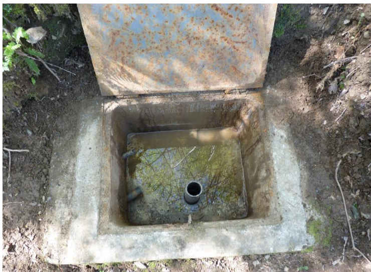
Figure 2 : Captages d'Artiguelongue (a : vue des deux ouvrages supérieurs ouverts c.a.d captage 1 et captage 2 avec au-dessus les pentes raides, b : vue du captage 1 ouvert situé au droit du versant avec absence d'arrivée d'eau, c : vue du captage 1 fermé sensible aux arrivées d'eaux superficielles et aux potentiels éboulements, d : vue du captage 2 ouvert)
