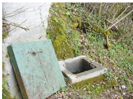
Figure 9 : Ouvrage collecteur
