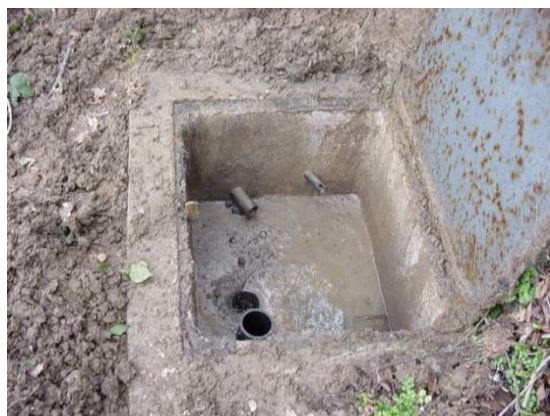
Figure 7 : Ouvrage de captage et dessablage
