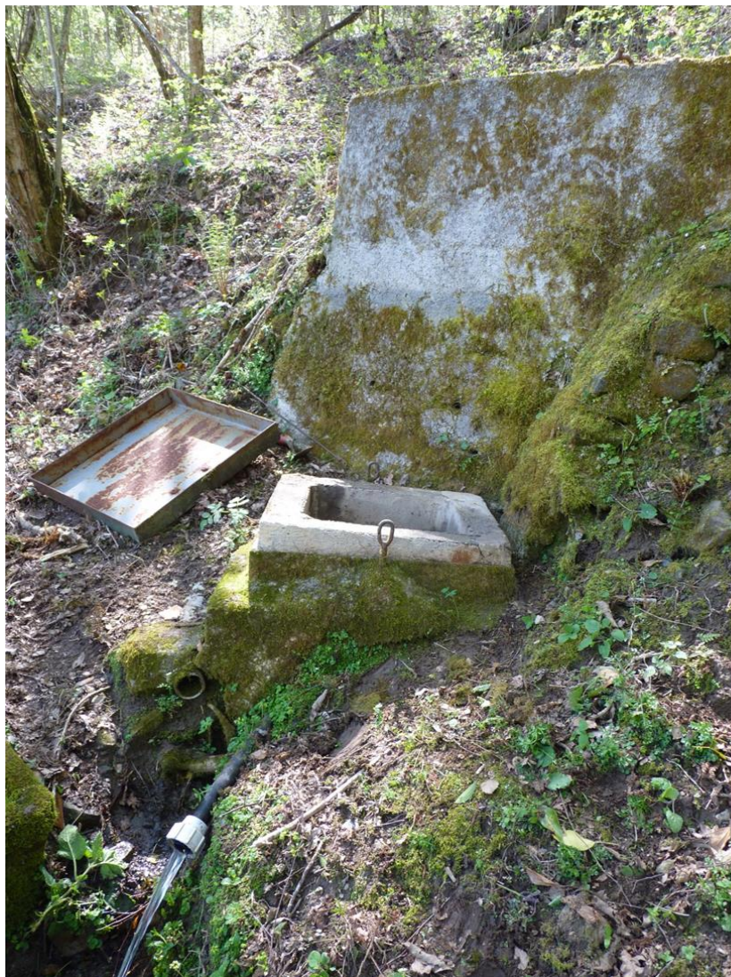
Figure 3 : Captages d'Artiguelongue (a : vue d'ensemble du répartiteur situé au droit du muret sous le sentier. Notez le trop plein ou la mesure de débit a été effectuée, b : vue depuis le sentier du répartiteur fermé, c : vue de l'arrivée d'eau dans le répartiteur, de la conduite de trop plein et de la conduite amenant au réservoir)
