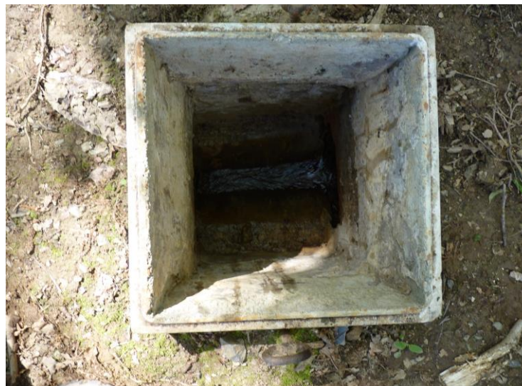
Figure 2 : Captages d'Artiguelongue (a : vue des deux ouvrages supérieurs ouverts c.a.d captage 1 et captage 2 avec au-dessus les pentes raides, b : vue du captage 1 ouvert situé au droit du versant avec absence d'arrivée d'eau, c : vue du captage 1 fermé sensible aux arrivées d'eaux superficielles et aux potentiels éboulements, d : vue du captage 2 ouvert)
