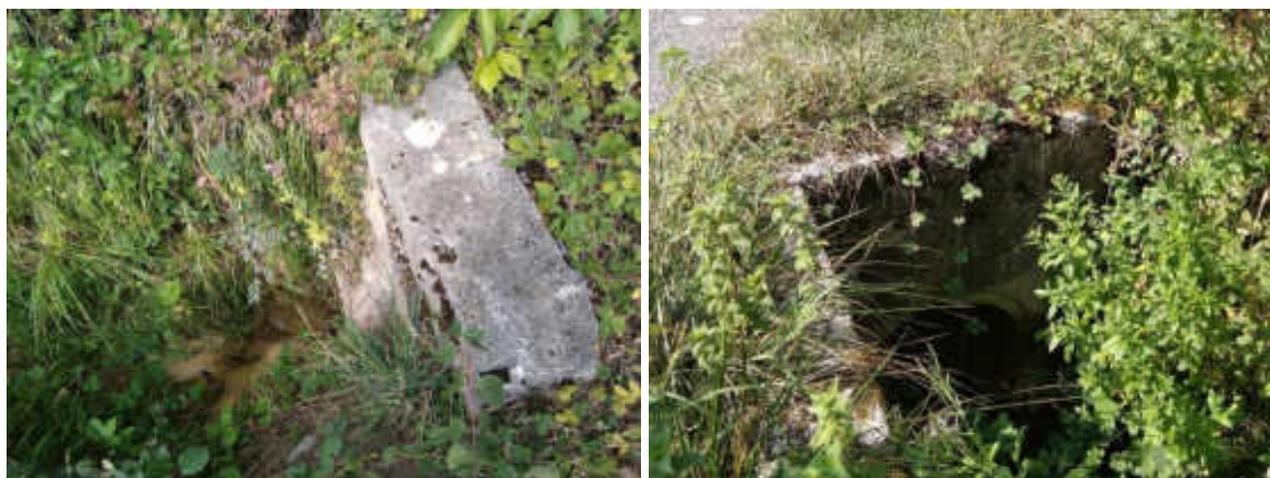
Figure 13 : entonnement amont (à gauche) et exutoire aval (à droite) du franchissement de la RD23
