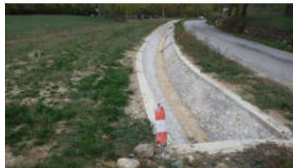
Fossé créé en 2022 en bordure de la route au Sud
