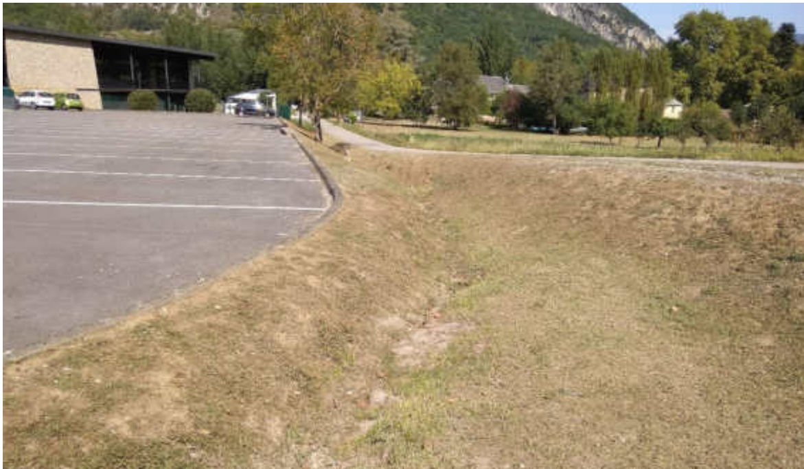
Figure 12 : fossé en terre bien entretenu recueillant la totalité des eaux pluviales du secteur du Parc et les écoulements résiduels du talweg
