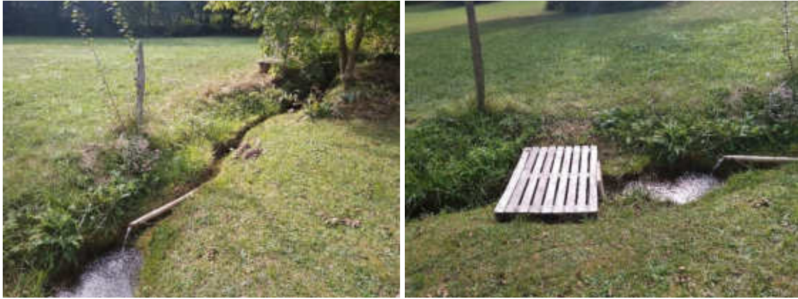
Figure 9 : aménagements privés du ruisseau en amont de la RD23
