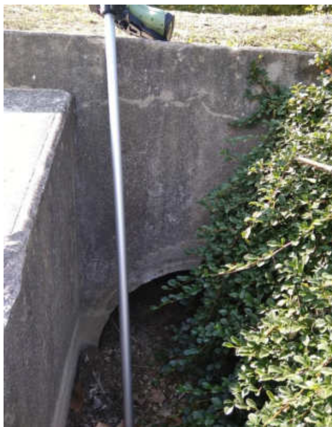
Figure 16 : ouvrage busé sous l'accès au Parc
