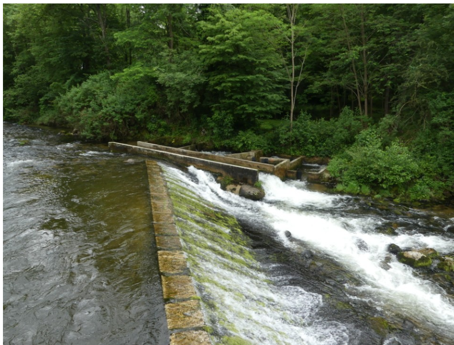
Photos 5 et 6 : Barrage, passe à poissons, passe à canoës et prise d'eau de la centrale hydroélectrique de Château Verdun (juin et octobre 2020)
