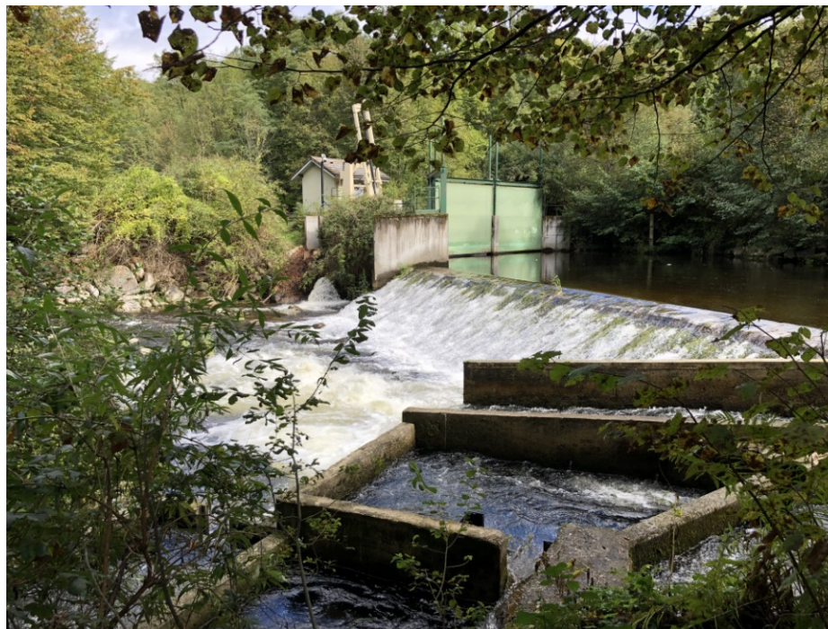
Photos 5 et 6 : Barrage, passe à poissons, passe à canoës et prise d'eau de la centrale hydroélectrique de Château Verdun (juin et octobre 2020)
