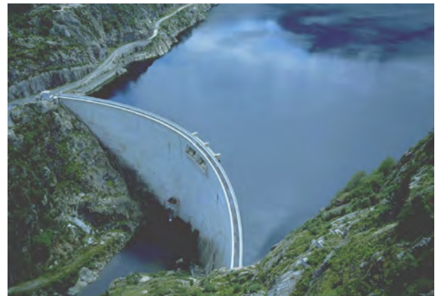
> Barrage de Laparan, Aston - Source : ERDF
