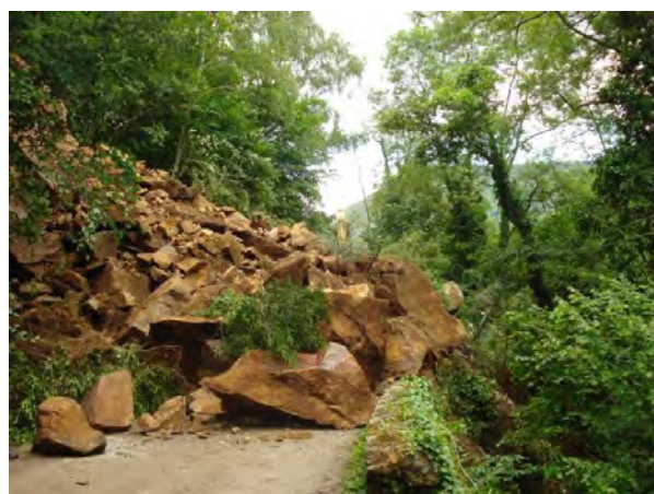
> Chute de blocs sur la RD20, Arnave – Source DPT Ariège
