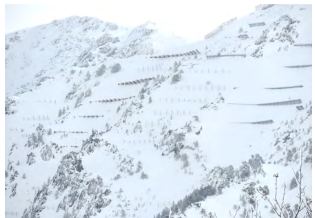
> Filets paravalanches, rateliers et claies à neige à l'Hospitalet-près l'Andorre - Source RTM 09
