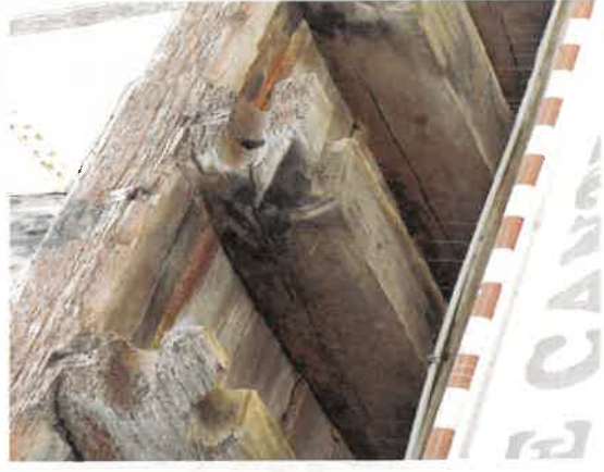
3. Maison 6 rue Maréchal Clauzel
