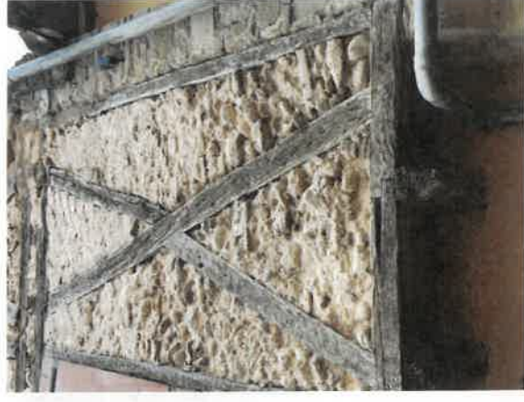
5. Maison. remplissage en galets
