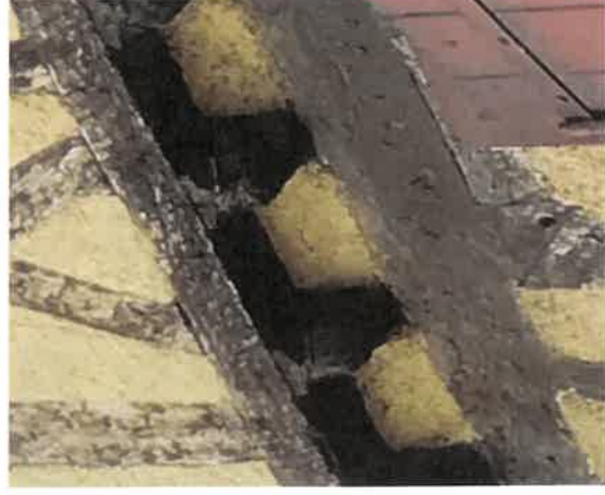
2. Maison 6 rue Maréchal Clauzel
