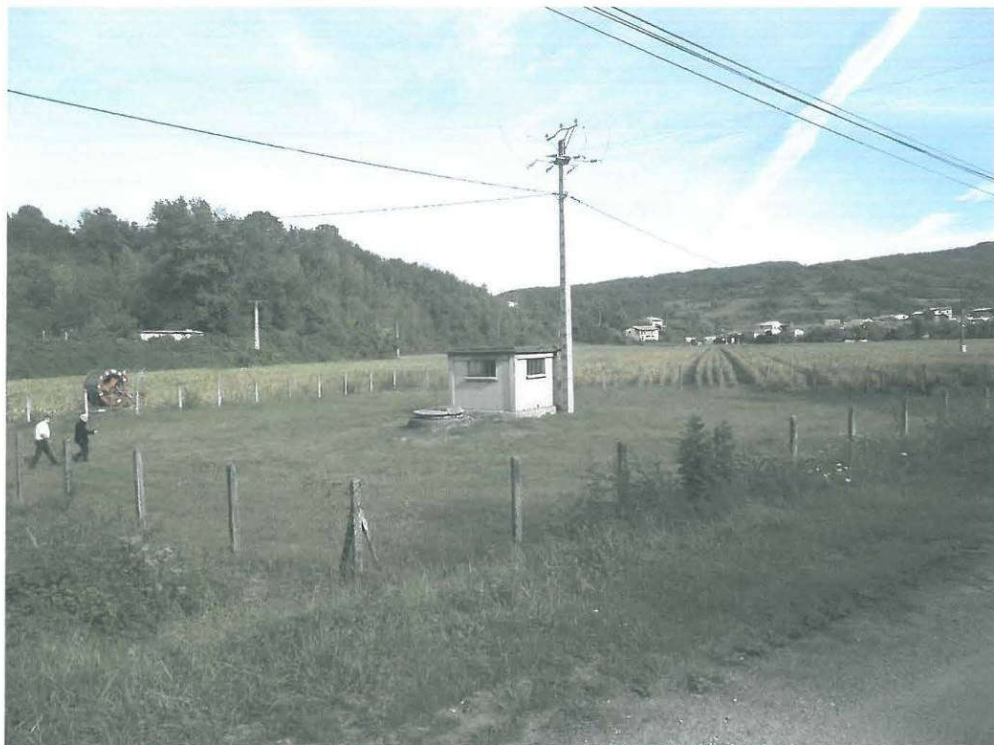
Figure 6 : Cliché du site (puits et local technique)
